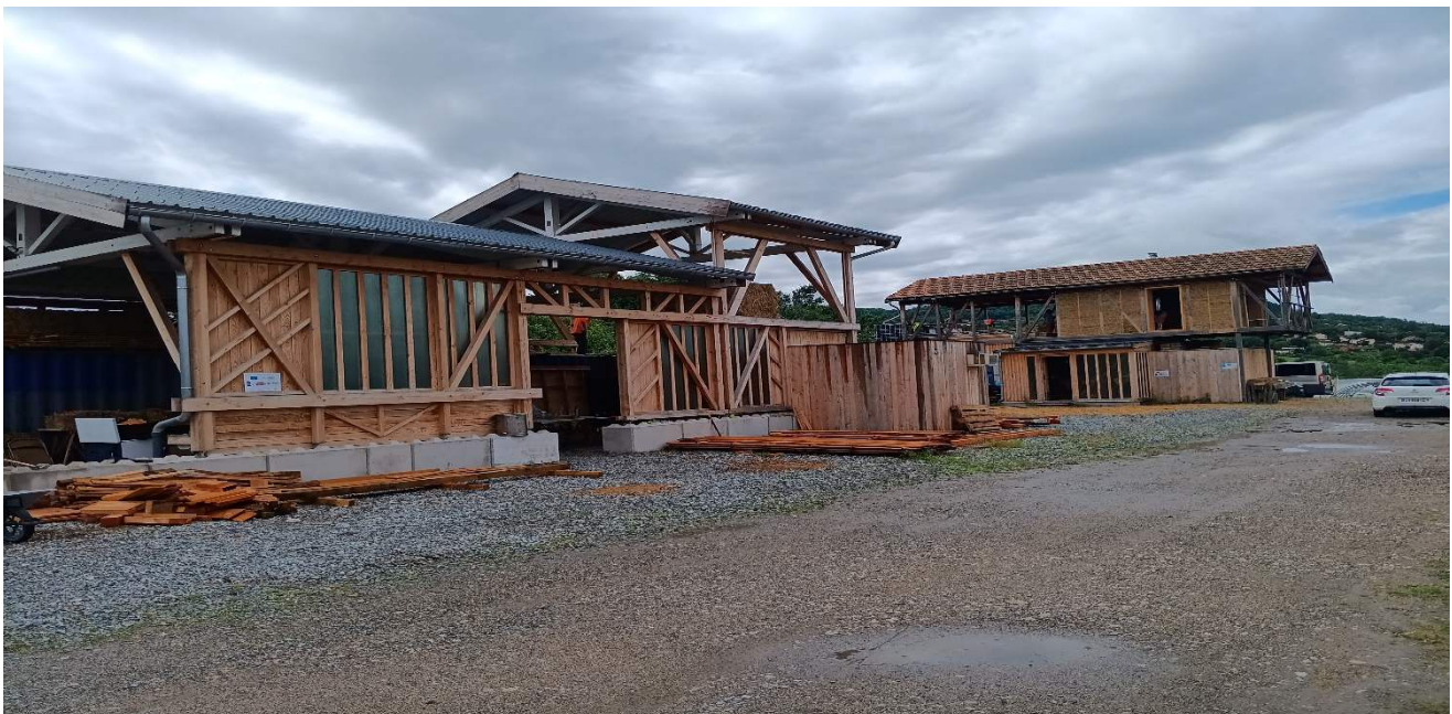
Construction des bâtiments de l'Ecopôle
