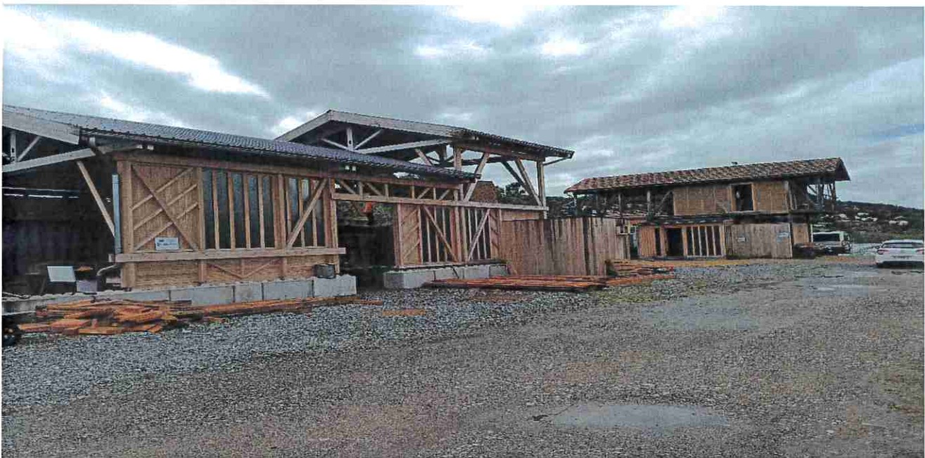
Construction des bâtiments de l'Ecopôle
